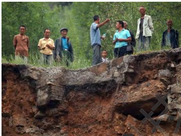
山西吕梁：临县煤矿采空区塌陷
